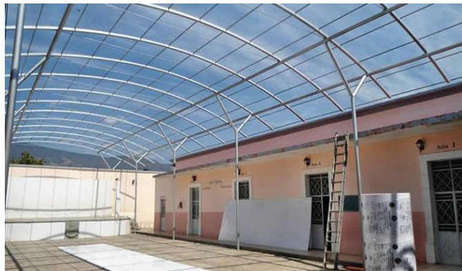
COLOCACIÓN DE CUBIERTA PATIO CENTRAL CASA DE LA CULTURA, SAYULA.
