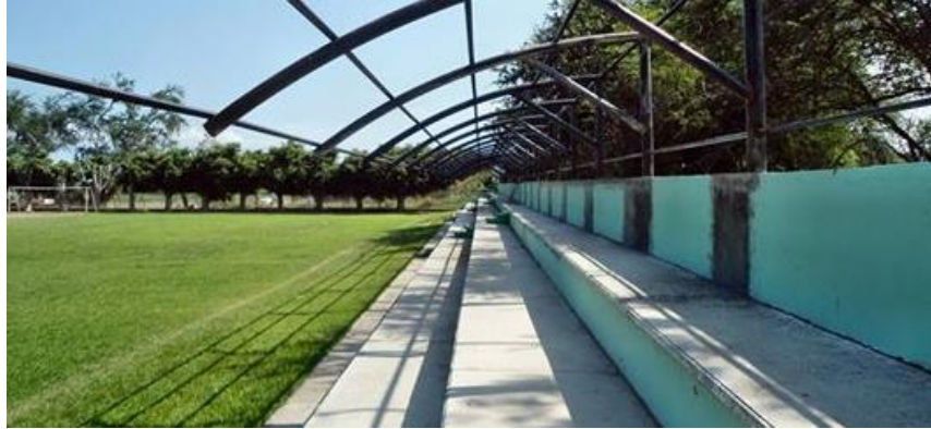
CUBIERTA EN GRADERIA, UNIDAD MARCELINO GARCIA BARRAGAN, USMAJAC.
